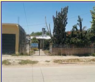
*Casa: 2 ambientes, 1 dormitorio, comedor, cocina, baño, lavadero, galería cubierta, Monasterio 928, G.Catán-
