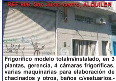
REF 906: San Justo centro, ALQUILER Frigorífico modelo totalm/instalado, en 3 plantas, gerencia, 4 cámaras frigoríficas, varias maquinarias para elaboración de chacinados y otros, baños c/vestuarios.-
