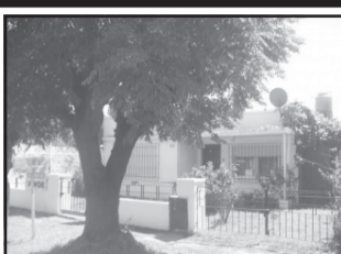
Casa 3 ambientes galería, patio, guarda útil, sobre Virgilio 3177 Morón, $ 1.100.000
