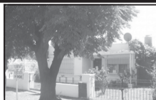
Casa 3 ambientes galería, patio, guarda útil, sobre Virgilio 3177 Morón, $ 1.100.000
