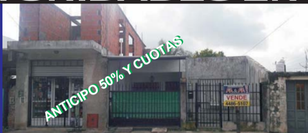
Sobre calle Albarracín, casa con local, 3 dormitorios, cocina comedor, comedor diario, living, 2 baños, local, lavadero, fondo libre, parrilla, entrada de auto, consulte.-
