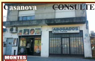
Casanova CONSULTE 1654) 2 locales c/depto 4 amb, c/galpón al fondo, lote 10x20, 200 m² edificados, Cristiania al 1300.-
