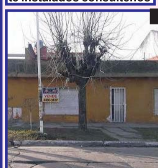
S/Seguí 3 dormitorios, living comedor, cocina, 2 baños, lavadero, garage, parrilla, entrada auto
