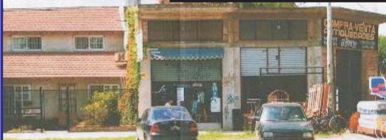
S/J.M.de Rosas CASA CON LOCALES 3 locales de 3x10 instalados altillo, Casa 2 dorm, cocina comedor, baño, lavad semi cubierto
